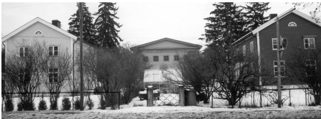
På fasaden på huset i midten står: Akers Elektrisitetsverk
