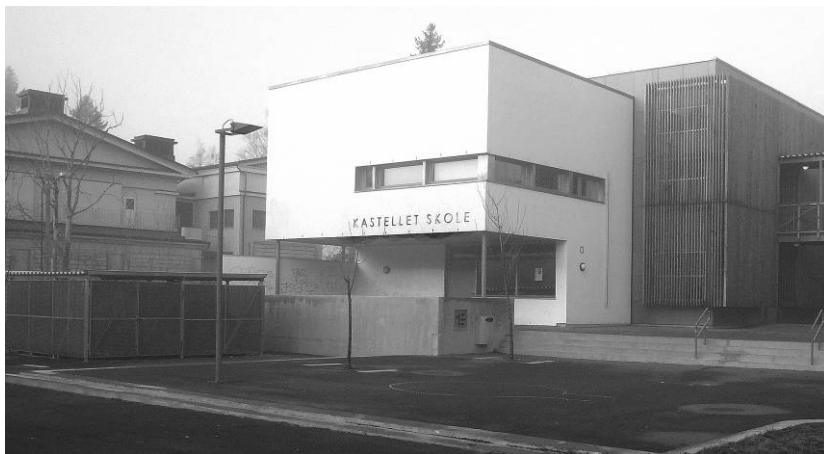
Skolen med Elektrisitetsverkets transformatorstasjon til venstre.
