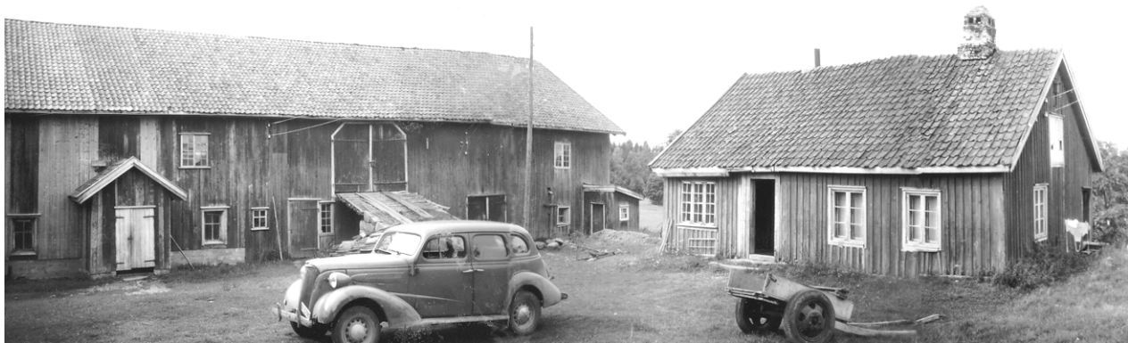
Låven og drenkestua på Nordseter gård
