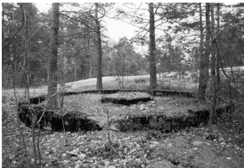
Det nordvestre ringfundament sterkt forvitret og bevokst.
