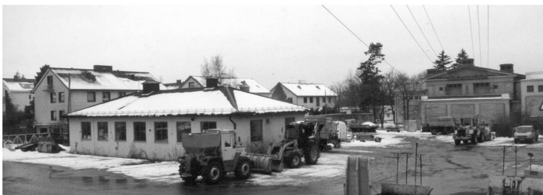
Veivesenets område før skolen ble bygget. Legg merke til høyspentkablene.
