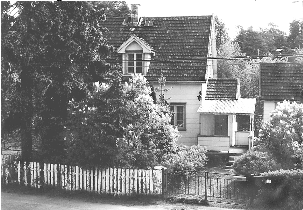
Hyggeveien 11 før det ble revet.
