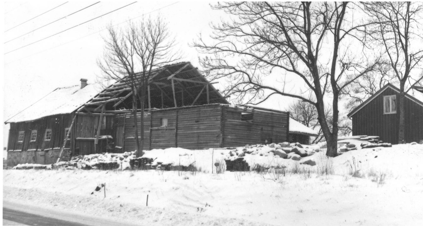
Låven på Søndre Hellerud rives. I forgrunnen Oberst Rodes vei. I dag ligger et stort rekkehus her. Til høyre drengestua som står i dag.
